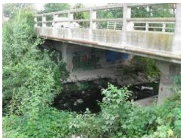
Slika 12: Most br. 02 u ulici Bore Kostića, km 1+044
