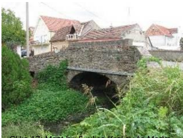
Slika 17: Most br. 5, ulica Kraljevića Marka, km 1+475
