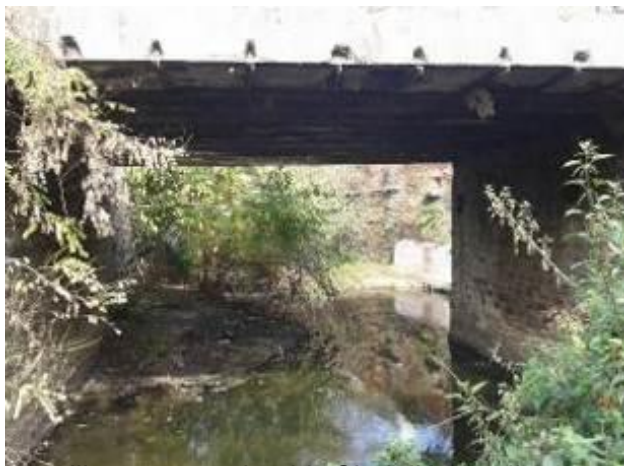
Slika 21: Most br. 09, Sindelićeva ulica, km 1+977
