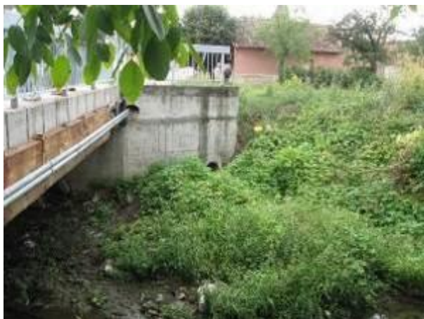
Slika 15: Most br. 3, Hajduk Veljkova ulica, km 1+268
