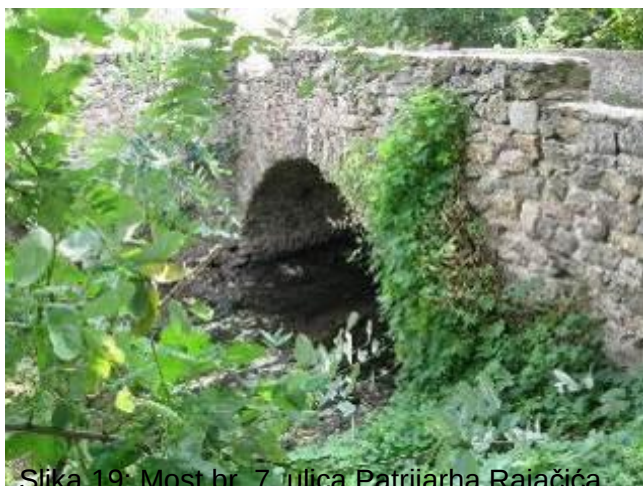
Slika 19: Most br. 7, ulica Patrijarha Rajačića, km 1+678
